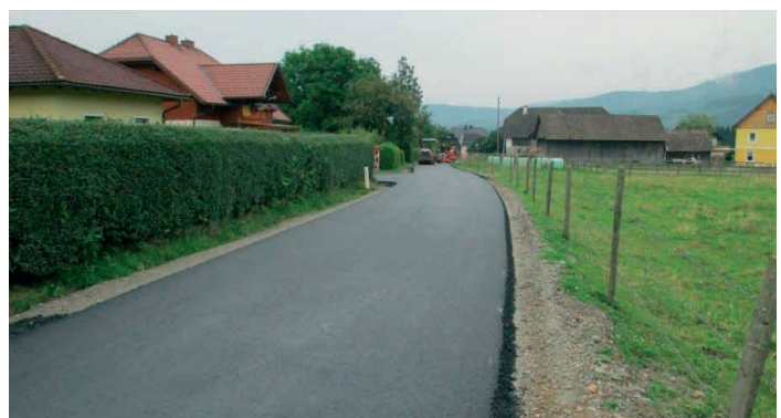
Asphaltierung nach Kanalbau Altenmarkt
