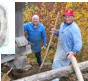
Herbert Salmina und Werner Rauscher bei der Arbeit am Fundament
