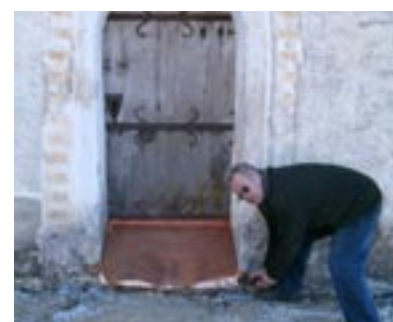
Karl Wissiak beim Anbringen eines Regenschutzes, um einer neueren Schädigung durch Regenwasser entgegenzuwirken.
